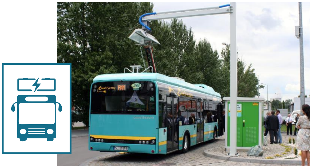
Rysunek 9: Pantografowa stacja ładowania autobusów elektrycznych w Jaworznie (źródło: https://www.transport-publiczny.pl/img/jaworznostacja1.jpg_678-443.jpg )
