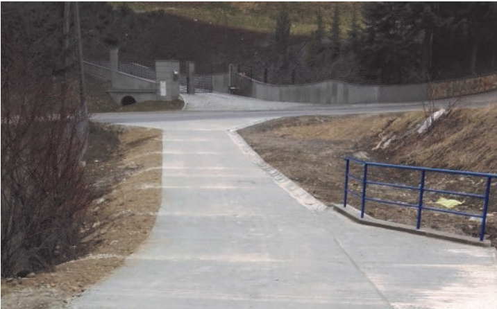
Remont drogi bocznej ul. Pułaskiego w Krynicy-Zdroju
