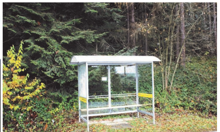
Montaż wiat przystankowych w Bereście i Czirnej
