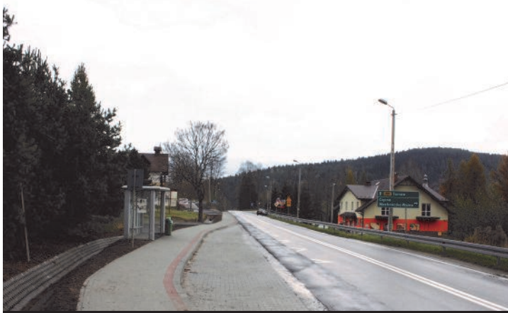
Budowa chodnika w Bereście
