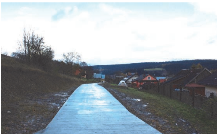
Remont drogi do pól w Piorunce
