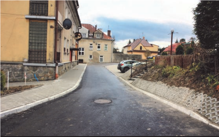
Remont drogi bocznej od ul. Halnej
