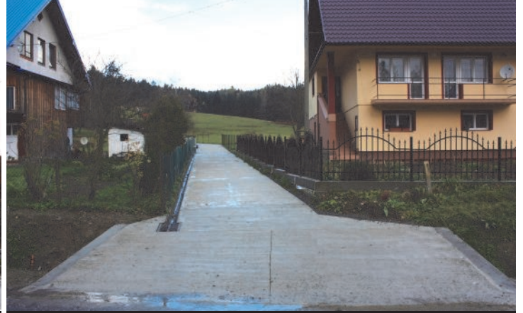
Remont drogi wewnętrznej w Polanach
