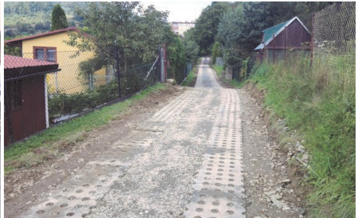
Remont drogi na ogródki działkowe na ul. Źródlanej
