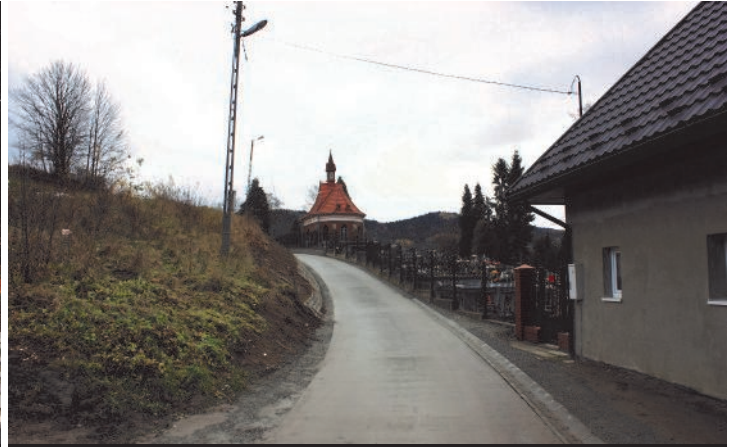
Remont ul. Św. Włodzimierza
