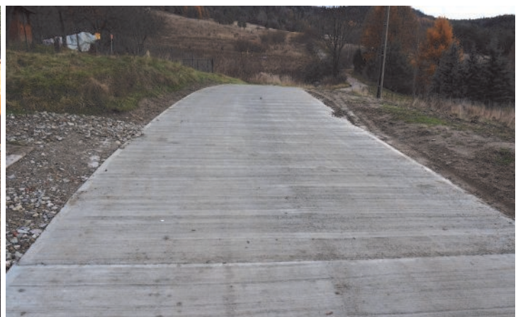
Remont drogi gminnej ul. Źródlanej – „na ogrody”
