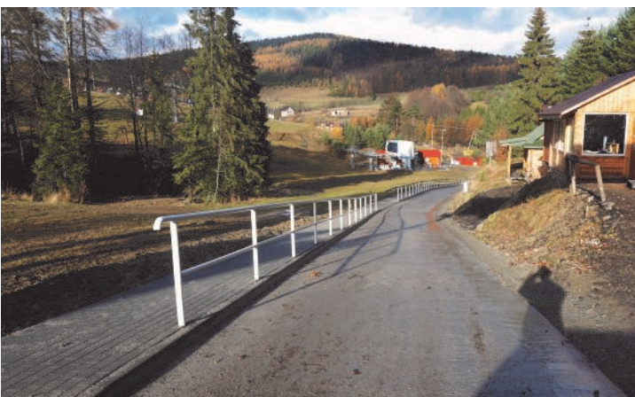
Wykonanie nawierzchni drogi wewnętrznej przy ul. Słotwińskiej
