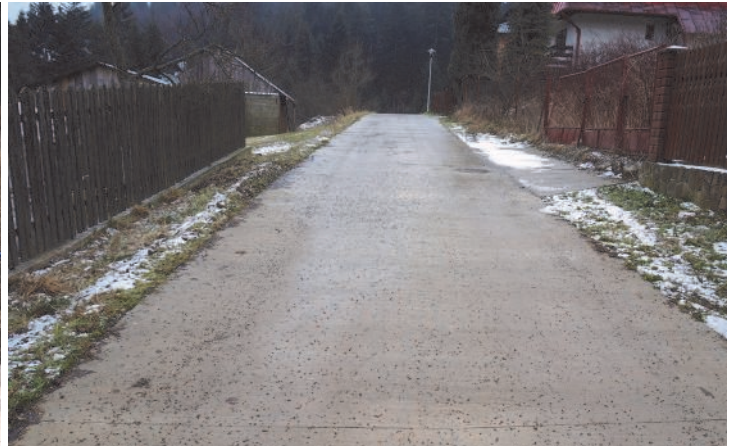
Remont drogi bocznej ul. Zielonej
