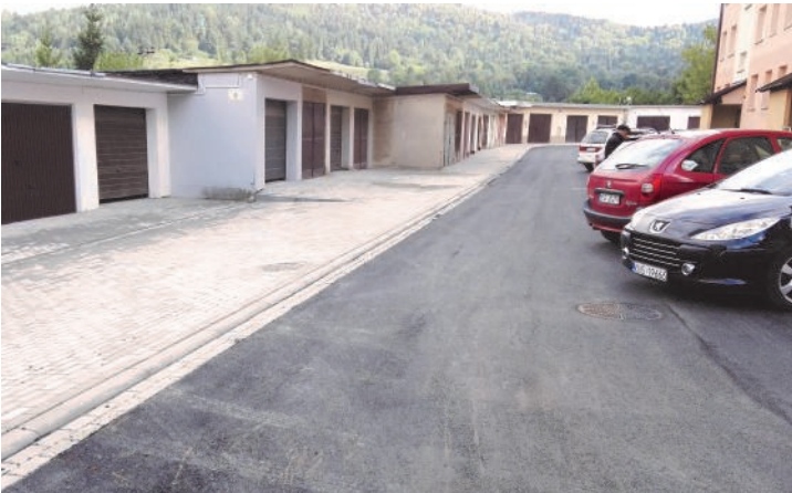
Remont drogi do bloku nr 43 na ul. Źródlanej
