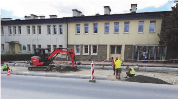
Przebudowa przystanku przy Szpitalu
