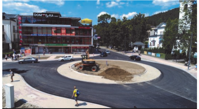
Budowa ronda przy Kościele Zdrojowym
