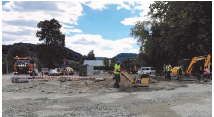
Budowa ronda przy Szpitalu
