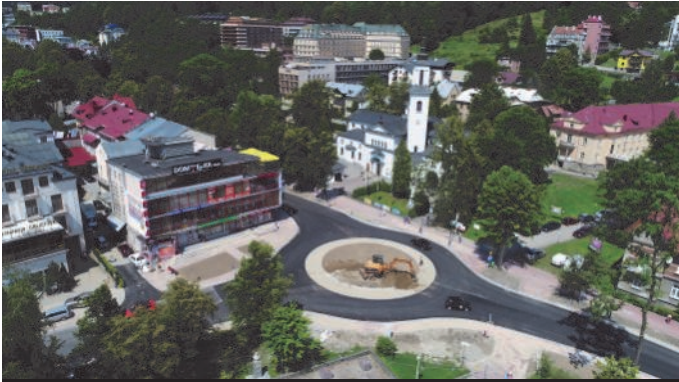
Budowa ronda przy Kościele Zdrojowym
